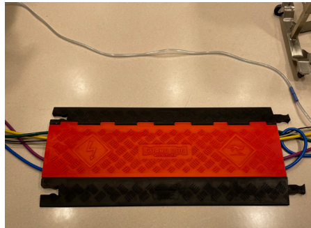
Figura 1. linhas de gás, cabo de dados, cabo de alimentação, tubo de sucção do aparelho de anestesia causando perigo de tropeçar.
